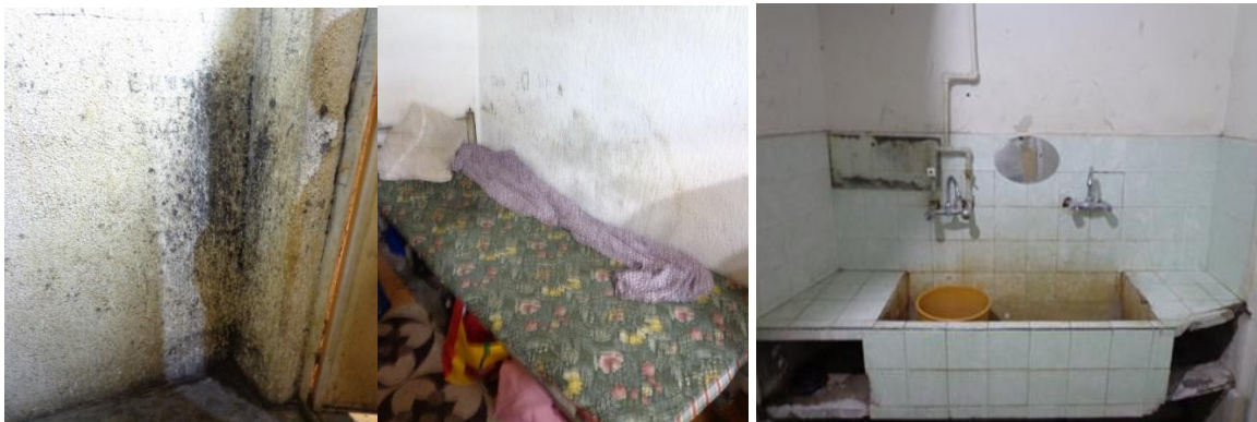
Спални помещения и обща чешма в Ареста на Районна служба „Изтърпяване на наказанията“ - Хасково
